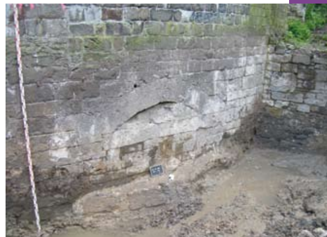
L'une des trois canonnières dégagées et les vestiges d'une tour de la seconde enceinte apparaissant sous la tour Henri VIII Photo M. Dosogne.
