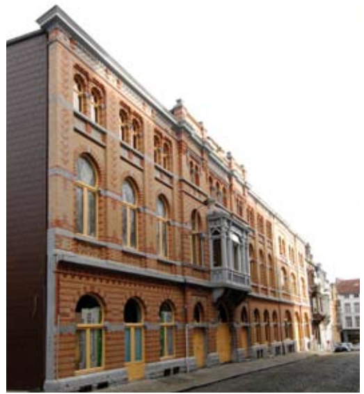
Le Grand Manège de Verviers après restauration G. Focant, DPat © MRW
