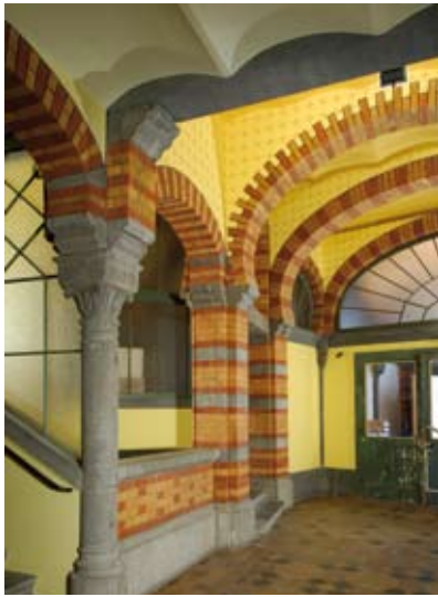
L'intérieur du Grand Manège restauré G. Focant, DPat © MRW
