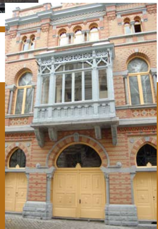
Loggia après restauration
