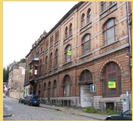
Façade principale avant restauration
