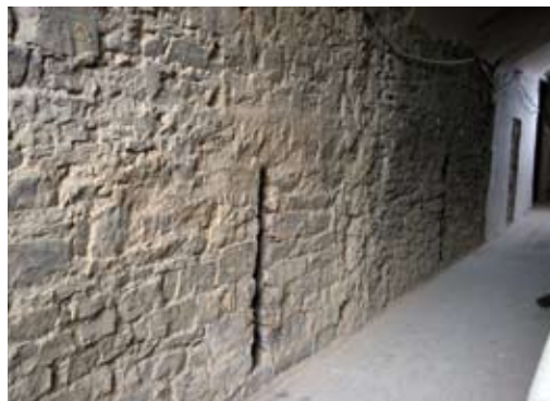
Chevet du chœur roman, mise au jour de fentes de lumière ayant assuré l'éclairage d'une crypte semi-enterrée. G. Focant, DPat © MRW
