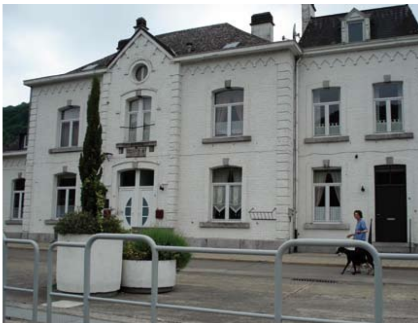
Maison éclusière en bord de Meuse. Photo D. Franquien © Archives photographiques namuroises
