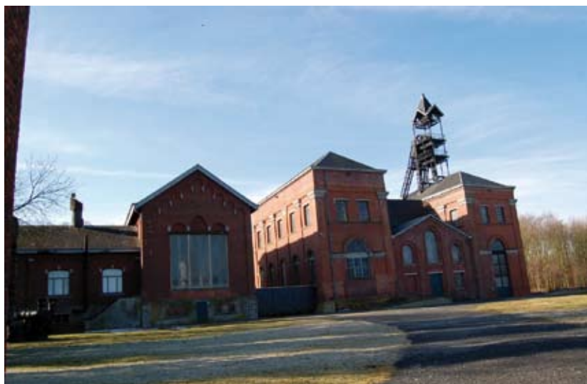
Vue de la fosse Saint-Emmanuel (1846-1920) © B. Vanroye
