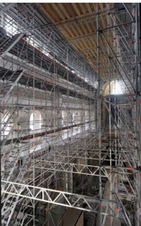
Nef, vue vers l'ouest, forêt d'échafaudages montés pour la réfection des enduits et du plafond. G. Focant, DPat © MRW
