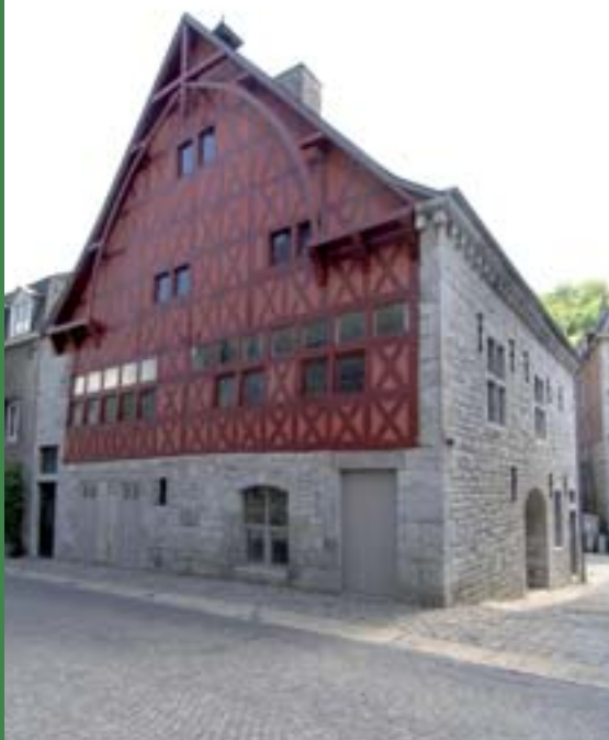
Halle de Durbuy restaurée - G. Focant, DPat © MRW
