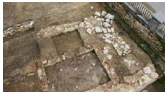
Jemeppe-sur-Meuse. Vue partielle du chantier © MRW
