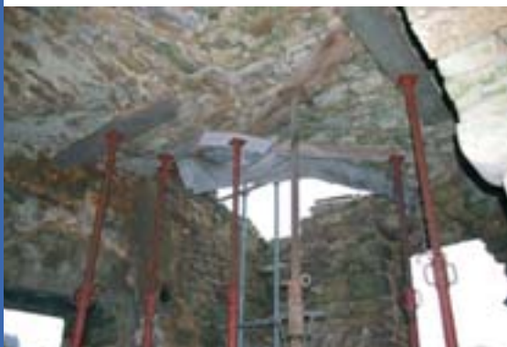
Étalement de la voûte © IPW
